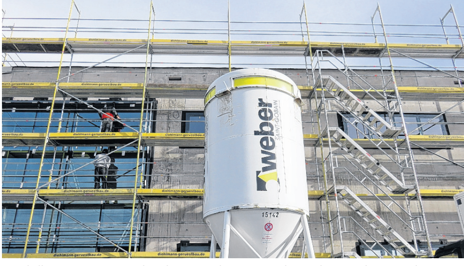
Innerhalb weniger Monate sind moderne Betriebsstätten aus dem Boden gewachsen, von denen einige schon in naher Zukunft bezogen werden können.
