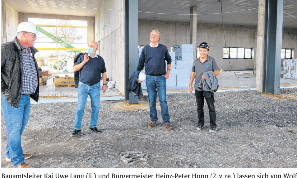
Bauamtsleiter Kai Uwe Lang (li.) und Bürgermeister Heinz-Peter Hopp (2. v. re.) lassen sich von Wolf Ehrenberg und Harry Jost (re.) die entstehenden Gebäude und Hallen vorstellen.
